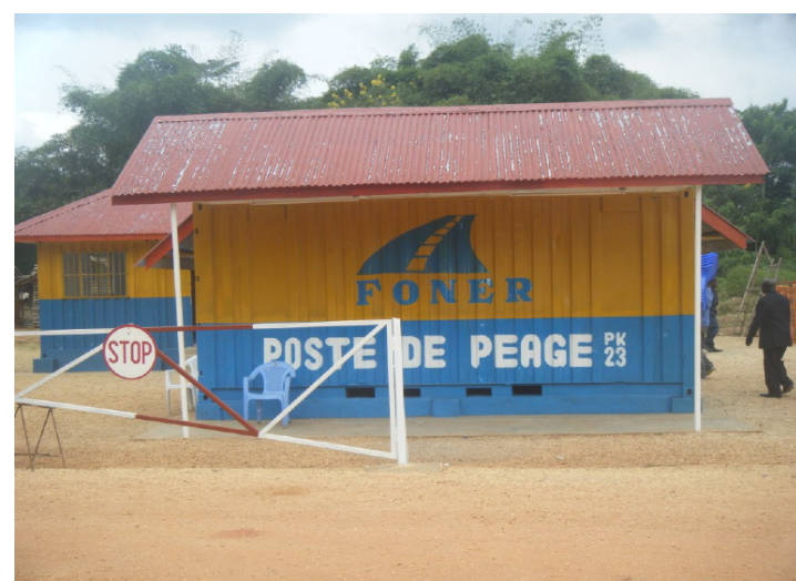
Un poste de péage sur la route Ituri récemment construit. (Crédit photo Mongongo)
